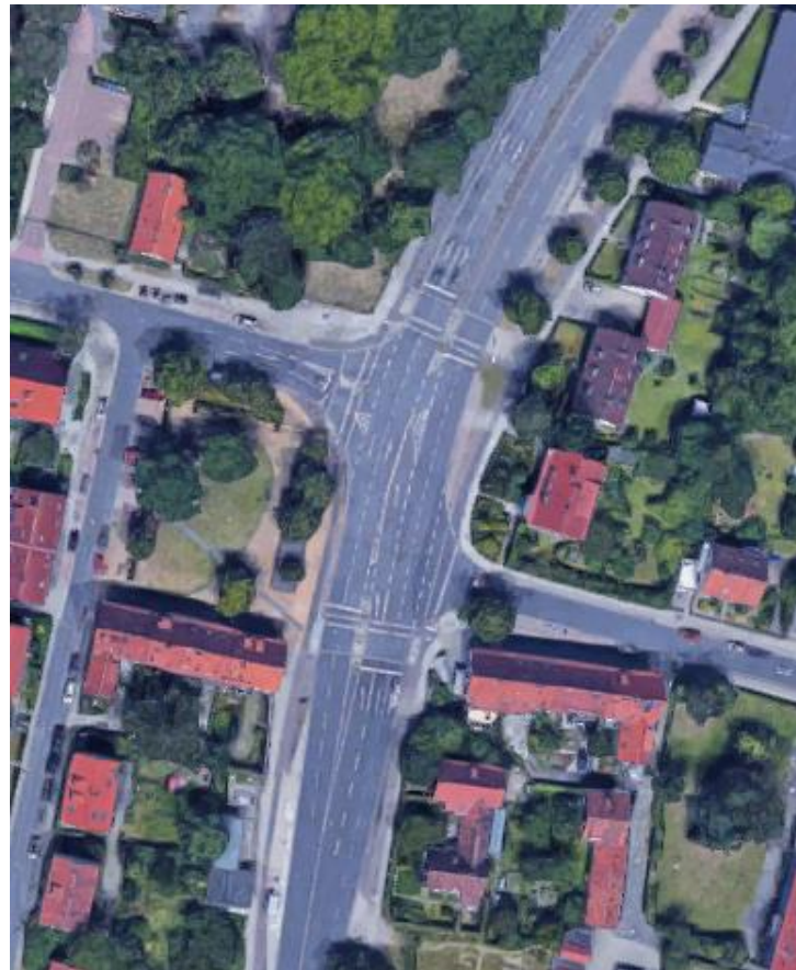
Abbildung 6: Tostmannplatz , Braunschweig; © Google Maps
